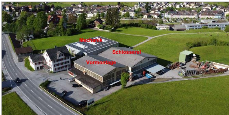
Abbildung 2: Situation Betriebsareal Fäh Maschinen- und Anlagenbau AG, Ansicht Süd-West
