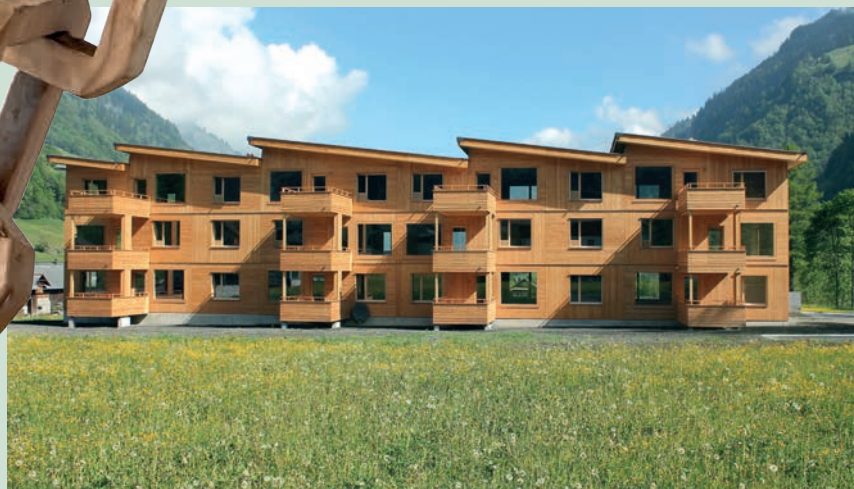
Mehrfamilienhaus aus Glarner Holz in Glarus Süd.
