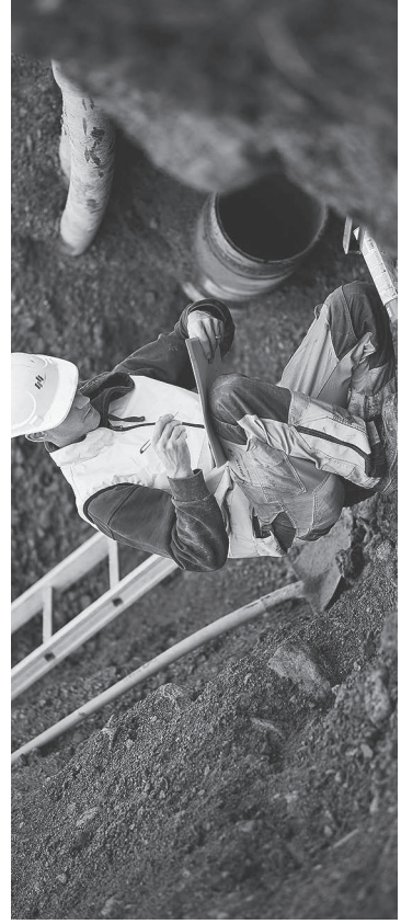
Arbeiten am Werkleitungsverbund Glarus-Netstal.
