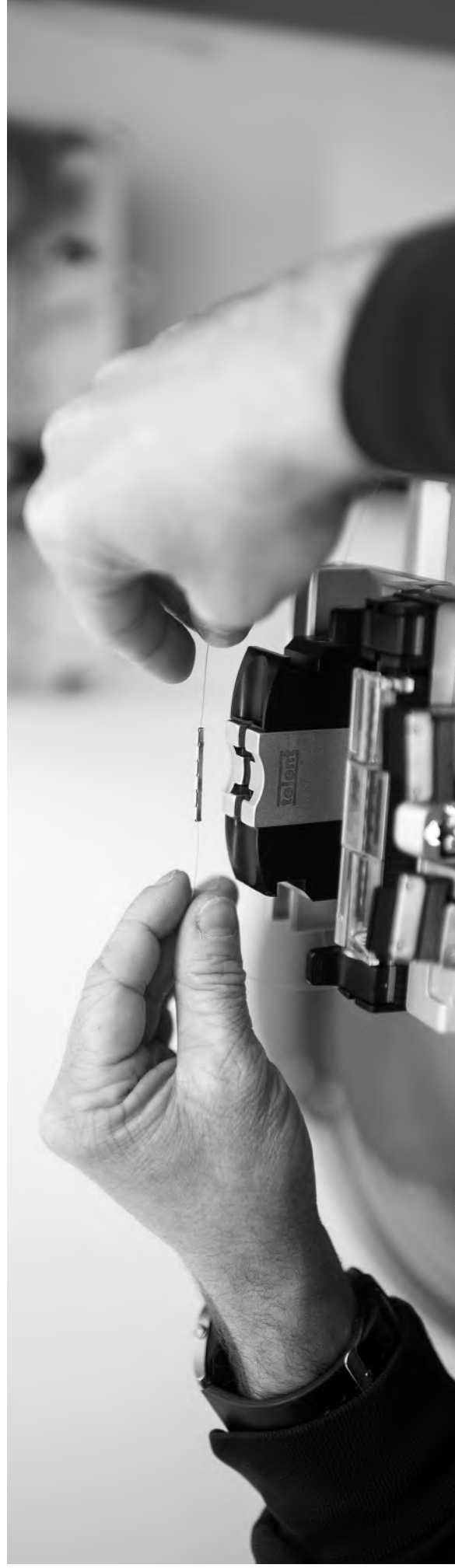
Verbindung von Lichtwellenleitern.
